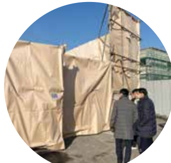
서종지점 공사 현장
