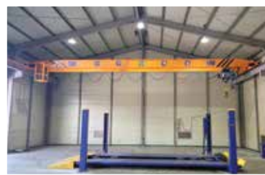
➔ 대형 호이스트 설치
